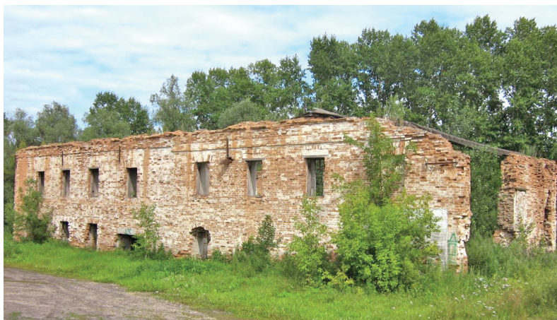
Рис. 6. Стена переднего фасада здания Павловского сереброплавильного завода
