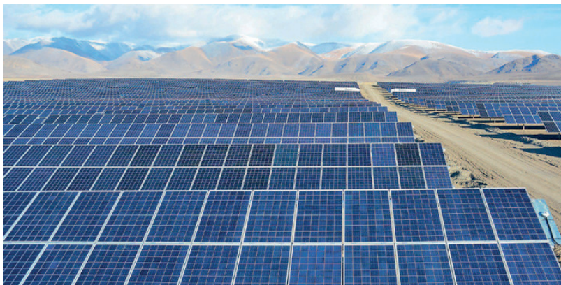
Рис. 1. Кош-Агачская солнечная электростанция в Республике Алтай
