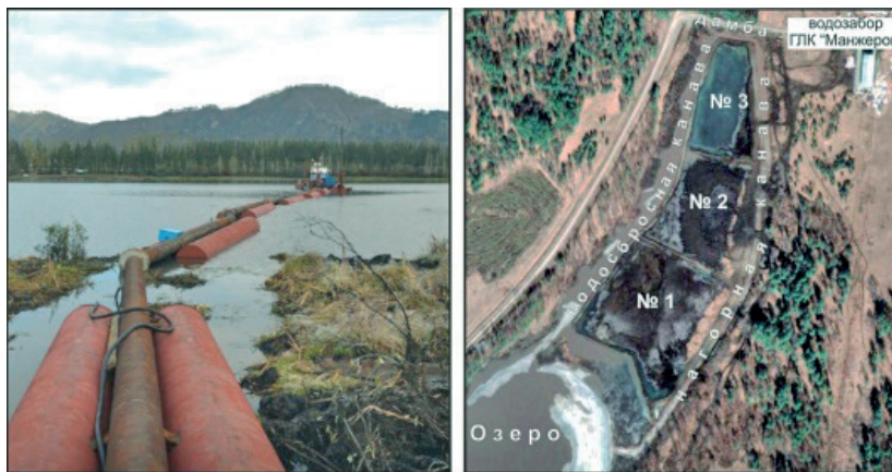
Рис. 3. Извлечение и транспортировка донных илов земснарядом (слева), Карты намыва илов № 1–3 в северо-восточной части озерной котловины (справа) [4]
