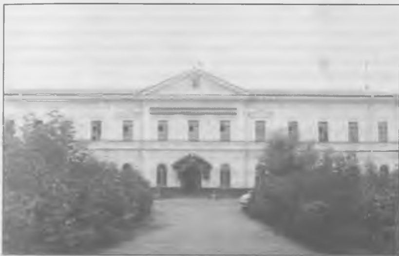
Улица Пушкинская, 82. Здание бывшего горного училища
