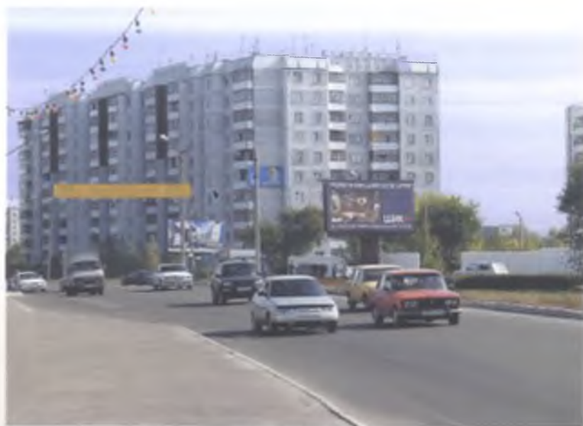
Строительство на Павловском тракте
