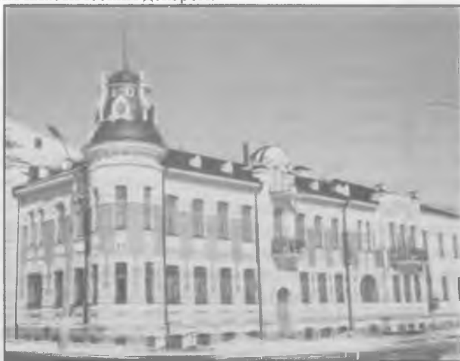
Улица Короленко. Здание начала XX в. (из фондов Главархитектуры Барнаула)
