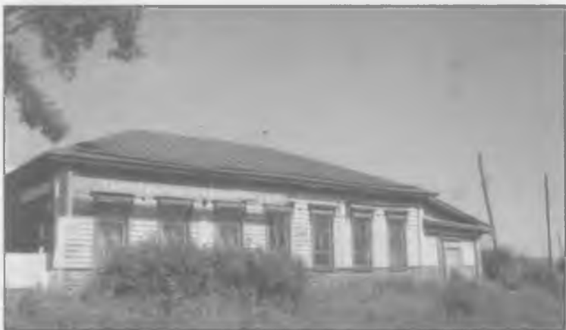
Улица Аванесова, 30. Здание бывшей Нагорной школы
