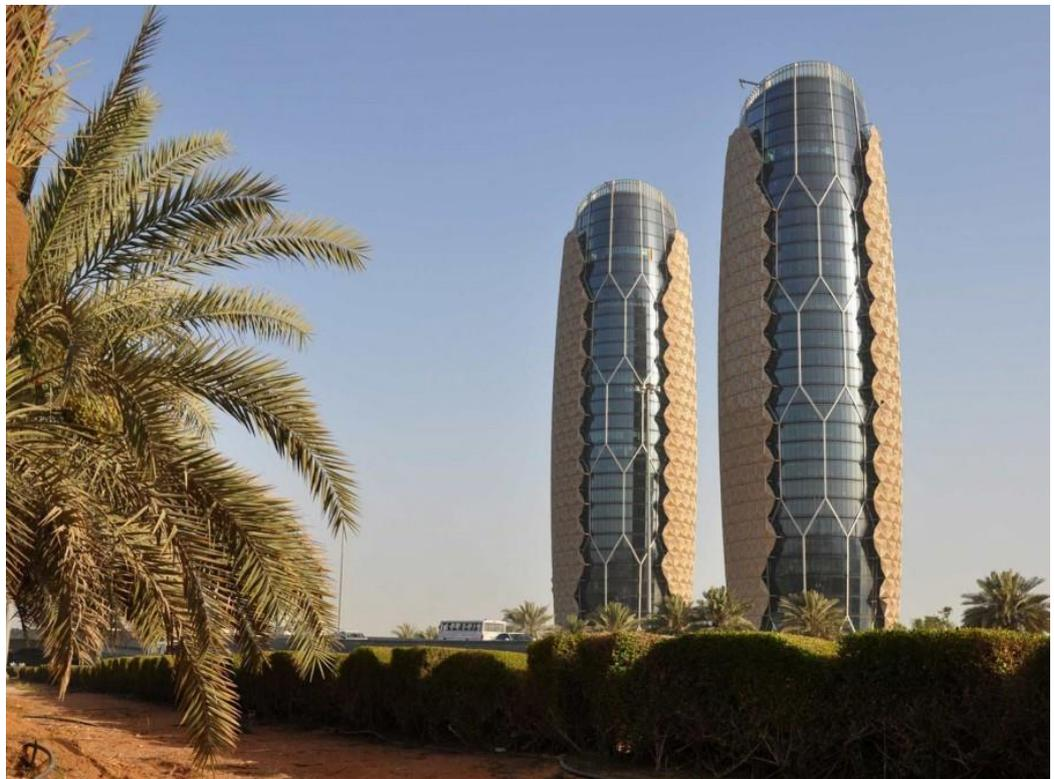
Иллюстрация 16 – Адаптивный фасад башен Al Bahar. 2012 г. Бюро Aedas Architects. ОАЭ[122]
