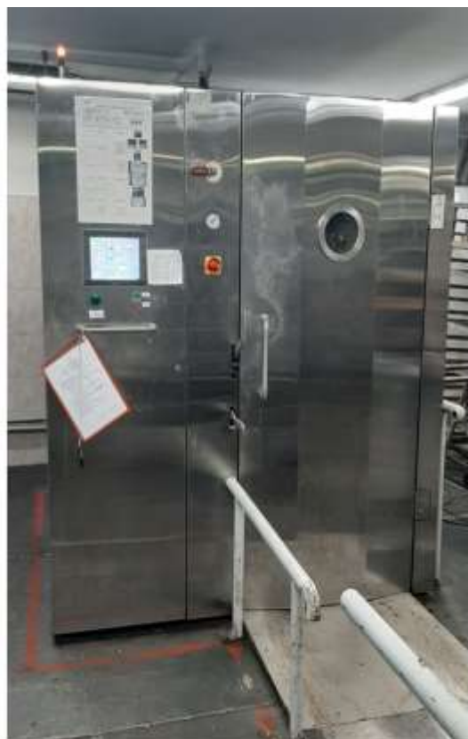
Рисунок 3.2.4-Установка вакуумной камеры
